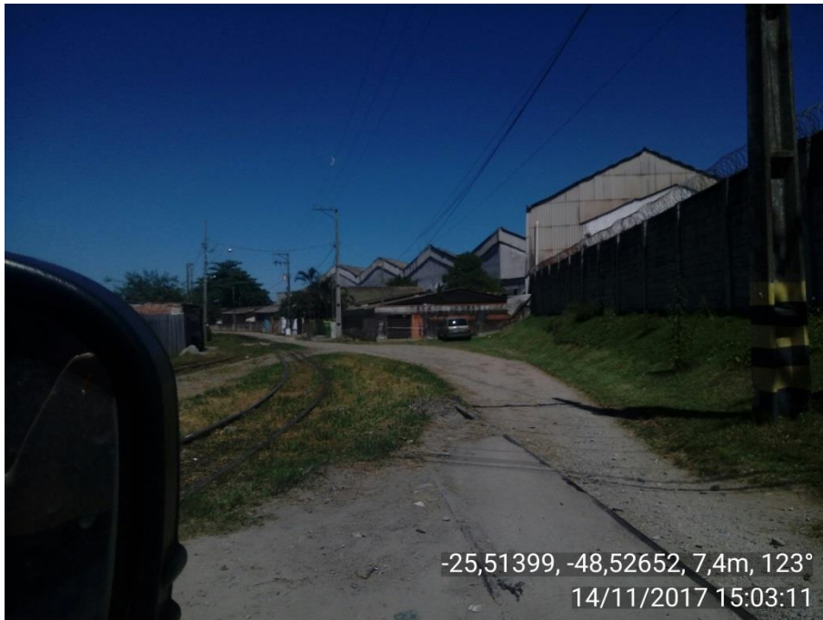
Figura 13: Vista da lateral do imóvel, lindeiro à linha ferroviária.
