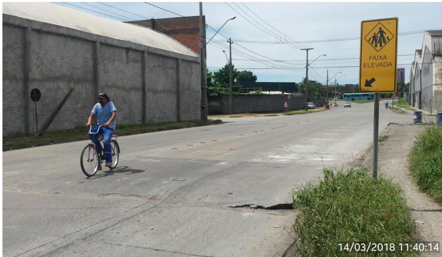
Figura 16: Segunda travessia elevada na Av. Cel. Santa Rita, próximo ao cruzamento com a R. José Cadilhe e ferrovia.
